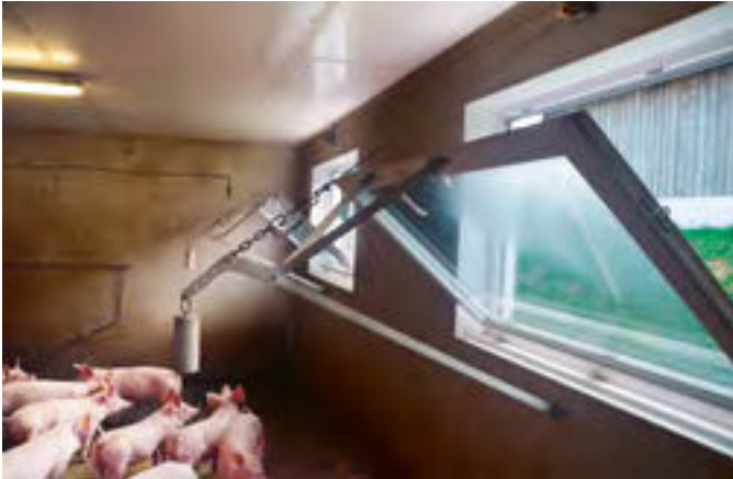
Gewichte am Seilzug ziehen die Kippfenster nach unten.
